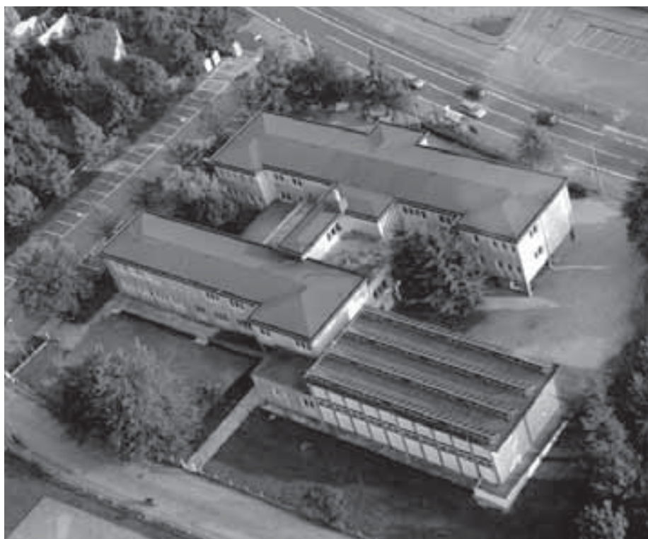
Foto aerea del prof. Lino Bianchin che riprende il tetto della palestra della scuola media ricoperto di pannelli fotovoltaici.
